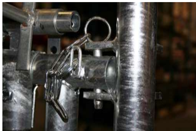
Låsning av front med bult – vänster sida
