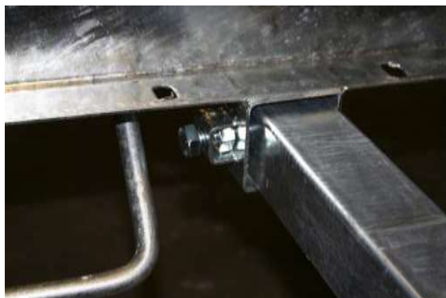
Hur infästningen till tvärstaget skall sitta
